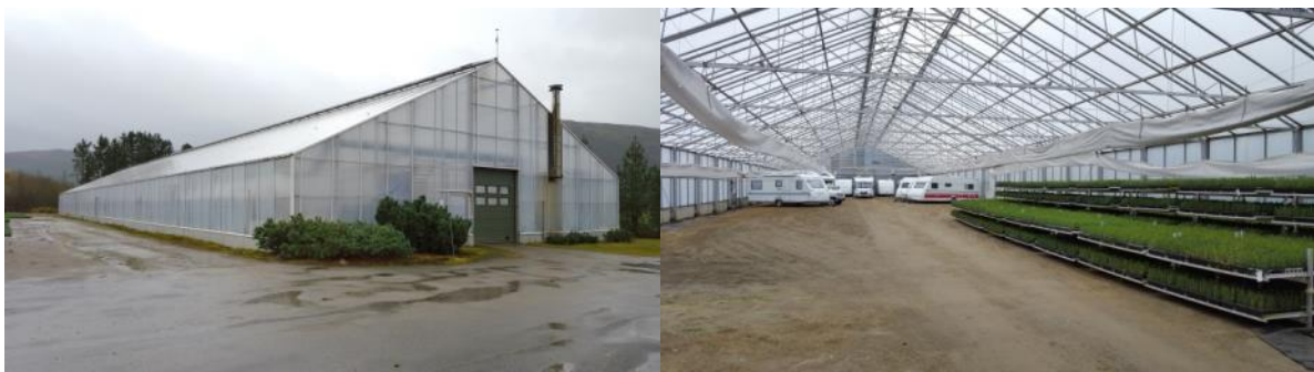
Figur 5: Veksthus 1 på 1500 m 2 som skal innredes for blomstringsindusering og stiklingproduksjon. Veksthuset er 20 m bredt og 75 m langt.
